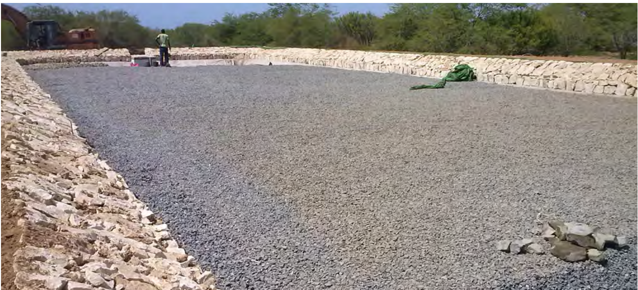
Vista del humedal de flujo horizontal en la fase final de construcción en Calheta de Maio
