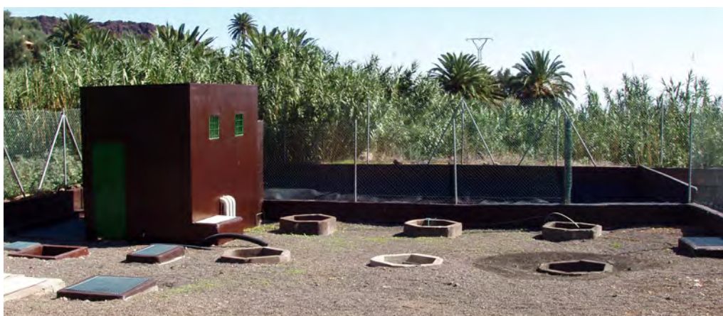
Vista general de la EDAR Temisas
