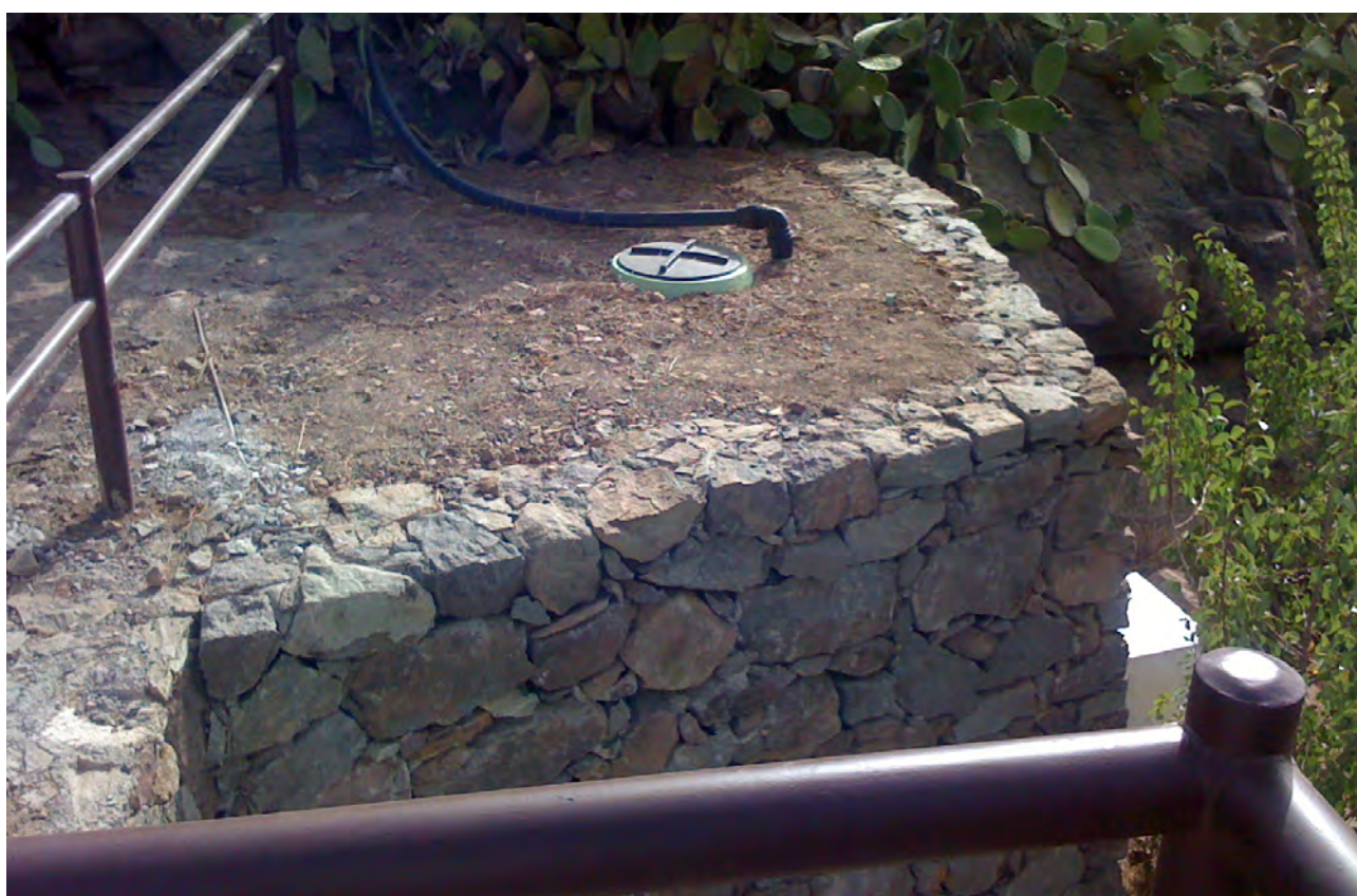
Imagen del tratamiento primario integrado en el entorno del Aula de la Naturaleza de Inagua
