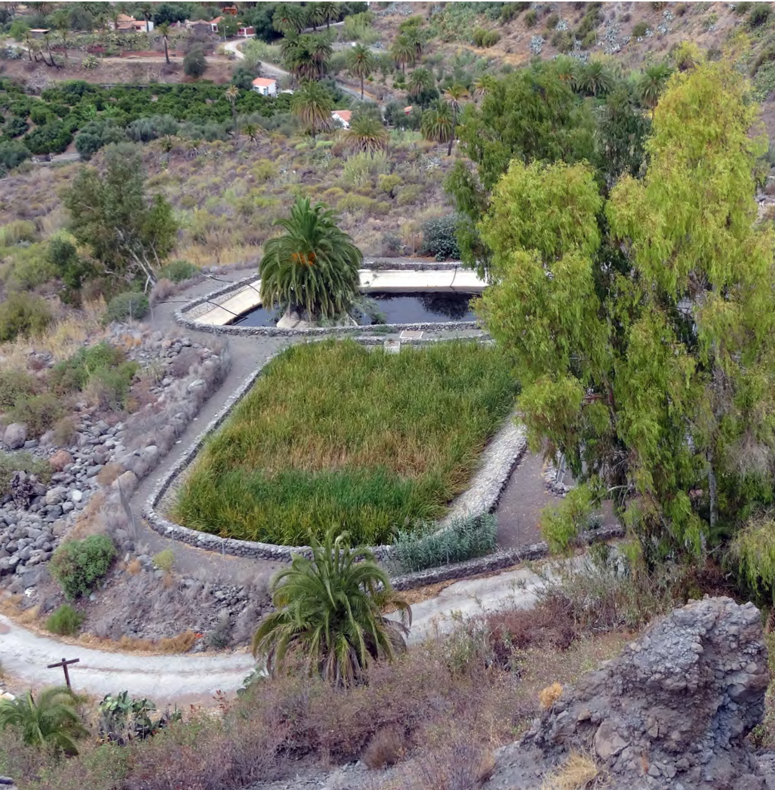
Vista del humedal de flujo horizontal y laguna de almacenamiento del SDN Santa Lucía
